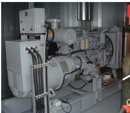
Netzersetanlage 100kVA
