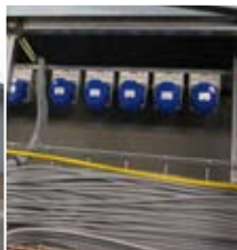
redundanter Stromanschluss
