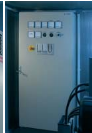
Notstromsteuerung Optional: Netzurücksynchronisation, Netzparallelbetrieb
