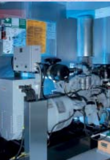
Netzersetzanlage startet bei Netzausfall in 5-10 Sekunden
