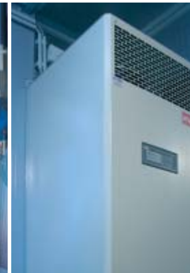
Klimagerät mit Freiluftkühlung spart Energie
