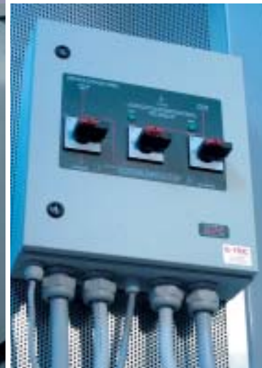
Bypass-Schalter für unterbrechungsfreien Service der USV-Anlage
